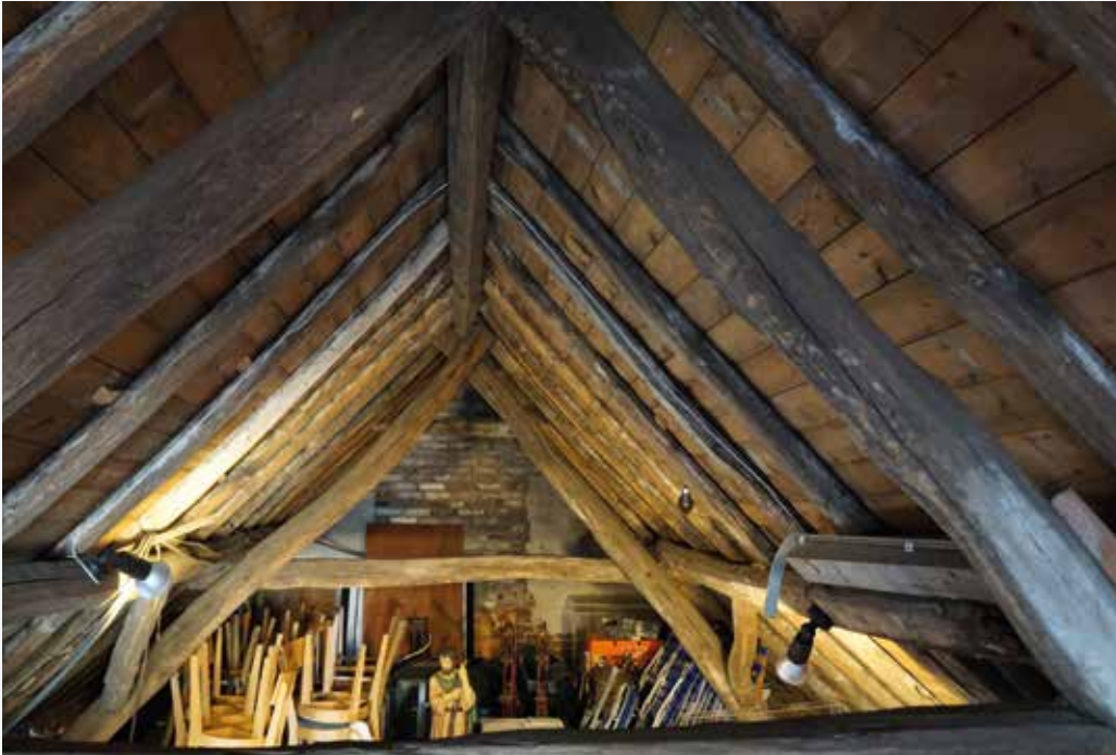
De originele kapconstructie van de werkplaats op Berg 34
